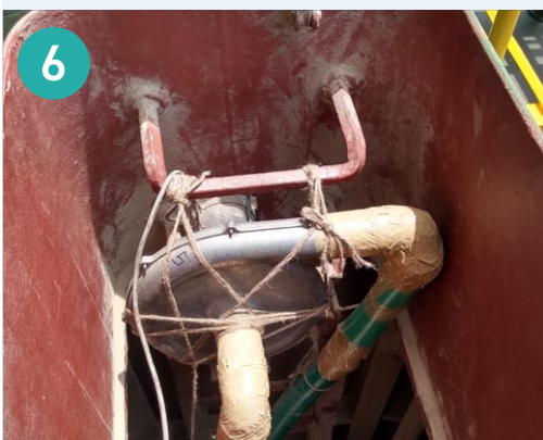
圖6: 不同國家(美國和印度)安裝於人孔的再循環風機案例
