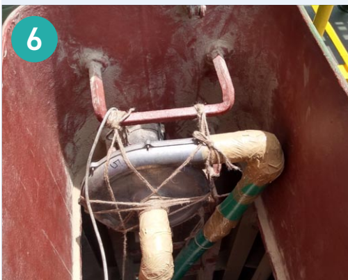
图6: 不同国家(美国和印度)安装于人孔的再循环风机案例
