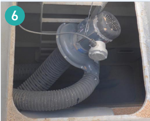
图6: 不同国家(美国和印度)安装于人孔的再循环风机案例
