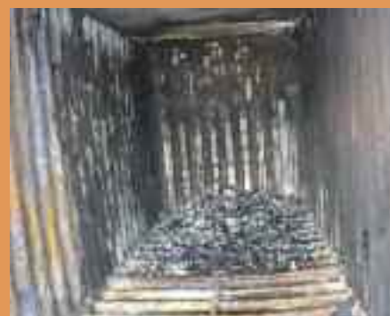
Vista desde el extremo de popa del contenedor mostrando que la mayor parte del suelo de plywood ha ardido, dejando las vigas de apoyo a la vista.
